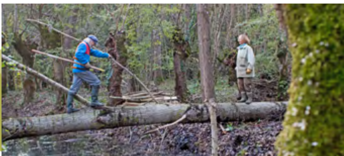
Chantier Galuchet - novembre 2015 ©Y. Maufras
